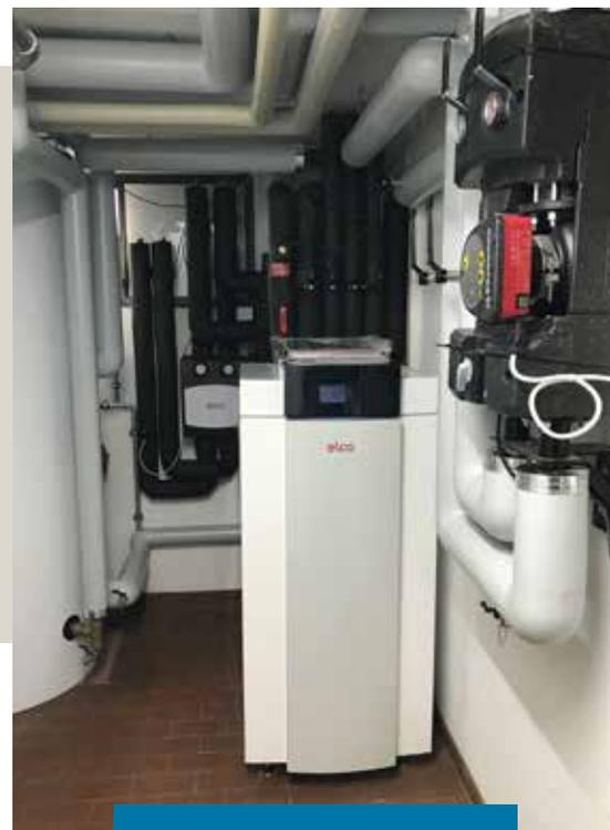
Beispiel einer Ölheizungsanlage mit Brenner und Boiler.
